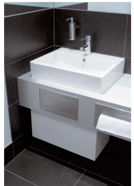
Dieser Waschtisch ist ein Eigenentwurf des Architektenteams Adolph + Seibel. Was alufarben schimmert, sind die Oberflächen „Metal on RESOPAL®“. Sie sollen auch im Sanitärbereich den High-Tech-Charakter der Panasonicprodukte widerspiegeln. Foto: Resopal
